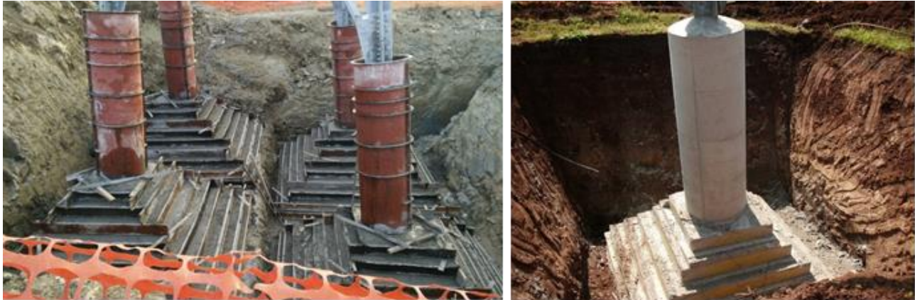
Figura 55: Apertura scavi per la realizzazione delle fondazioni. Per la demolizione delle fondazioni gli scavi saranno riaperti per la rimozione del plinto andando però a rimuovere il suolo già rimaneggiato nella fase di costruzione.
