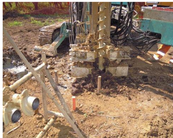
Figura 17: Macchina operatrice per la realizzazione di micropali tubfix. A sinistra sistema di scavo a rotopercussione, a destra sistema di scavo mediante trivella elicoidale.
