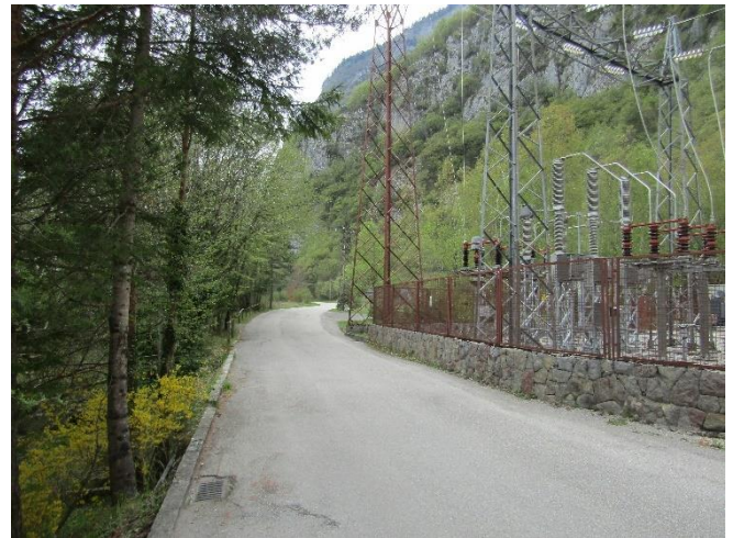
Figura 37 – Dettaglio della strada asfaltata interessata dallo scavo della trincea per la posa del cavo interrato
