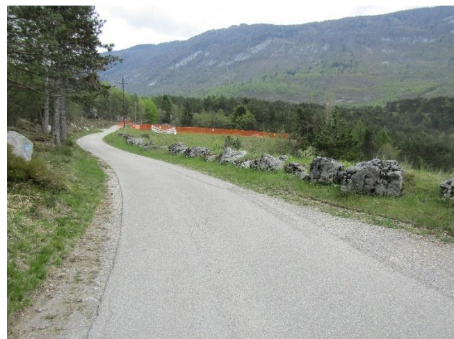
Figura 54 – Strada asfaltata interessata dalla posa dei cavi interrati. In lontananza il passaggio di transizione aereo-cavo
