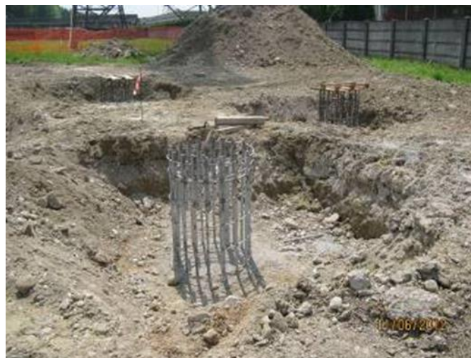
Figura 13: Macchina operatrice per la realizzazione di pali trivellati e fondazione in fase di realizzazione
