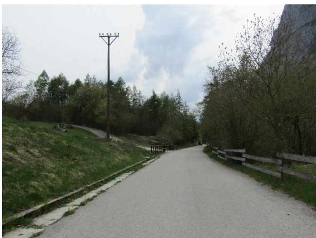
Figura 41 – Dettaglio della strada asfaltata interessata dallo scavo della trincea per la posa del cavo interrato
