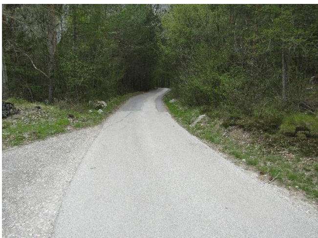
Figura 53 – Strada asfaltata interessata dalla posa dei cavi interrati
