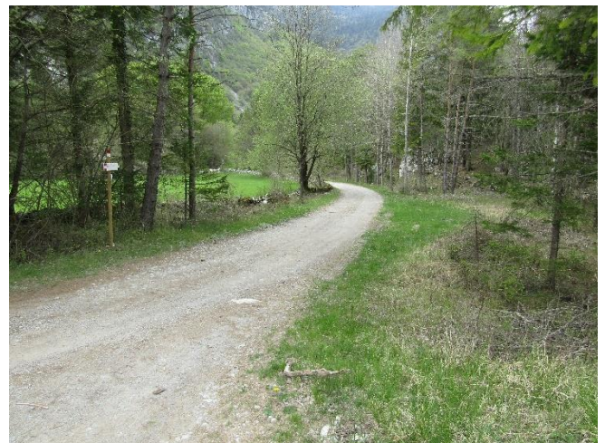
Figura 44 – Viabilità secondaria sterrata lungo la quale è previsto lo scavo della trincea per la posa del nuovo cavo interrato (a E della CP di Nembia)
