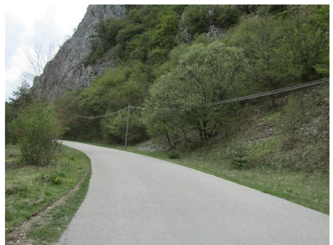
Figura 38 - Dettaglio della strada asfaltata interessata dallo scavo della trincea per la posa del cavo interrato
