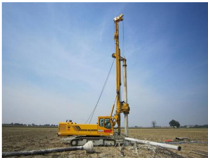
Figura 13: Macchina operatrice per la realizzazione di pali trivellati e fondazione in fase di realizzazione
