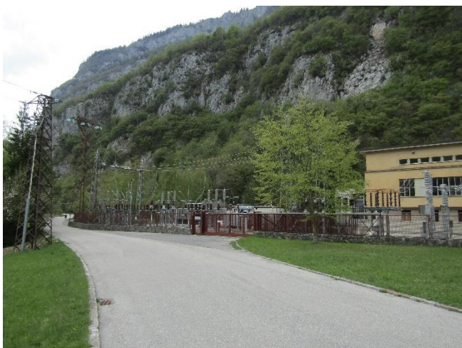
Figura 36 – Vista generale della Cp di Nembia e della strada asfaltata lungo la quale è previsto lo scavo della trincea per la posa del nuovo cavidotto interrato
