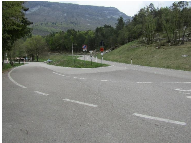
Figura 49 – Tratto di SS 421 interessato dallo scavo della trincea per la posa dei cavi interrati in progetto
