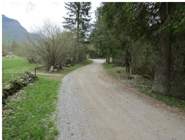
Figura 48 - Viabilità secondaria sterrata lungo la quale è previsto la posa del cavo interrato
