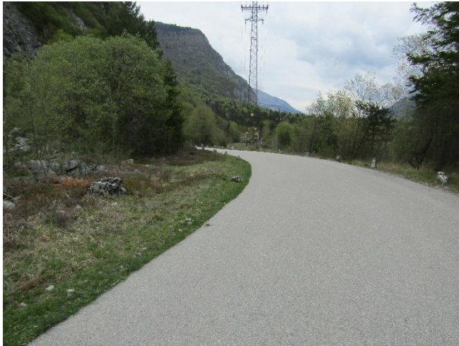
Figura 39 – Dettaglio della strada asfaltata interessata dallo scavo della trincea per la posa del cavo interrato
