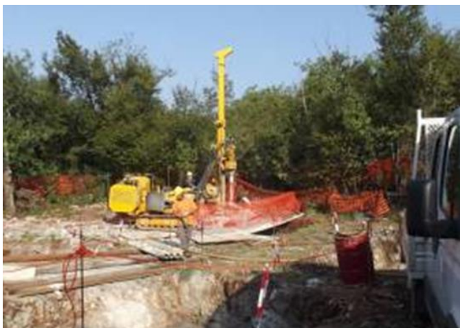
Figura 16: Esempio di realizzazione di fondazione su micropali tipo tubfix. Nell'immagine di destra è mostrato il raccordo tra i tubolari metallici dei micropali con l'armatura del plinto di fondazione; al centro del plinto si nota il moncone del sostegno (elemento di raccordo tra il sostegno e la fondazione), inglobato nella fondazione stessa.
