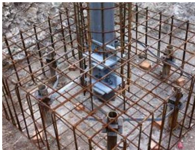
Figura 16: Esempio di realizzazione di fondazione su micropali tipo tubfix. Nell'immagine di destra è mostrato il raccordo tra i tubolari metallici dei micropali con l'armatura del plinto di fondazione; al centro del plinto si nota il moncone del sostegno (elemento di raccordo tra il sostegno e la fondazione), inglobato nella fondazione stessa.
