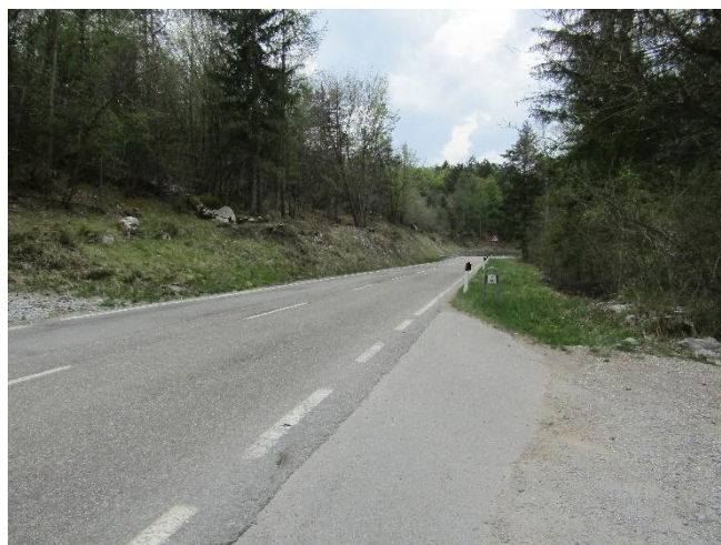
Figura 50 – SS421 nel tratto in cui sarà posato il cavidotto in progetto
