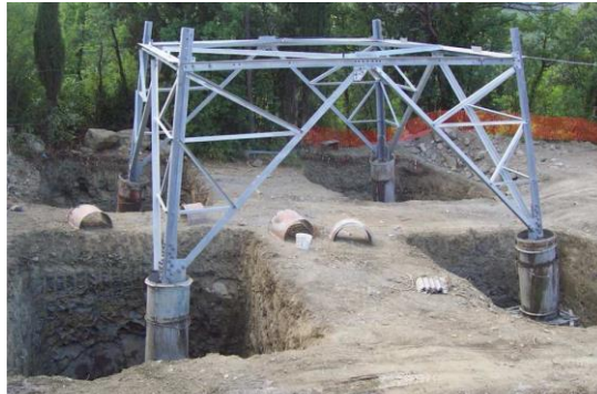
Figura 11: Realizzazione di fondazioni superficiali tipo CR per sostegno a traliccio. Si possono osservare le quattro buche, la base del sostegno collegata alla fondazione tramite i "monconi" ed i casseri utilizzati per i quattro "colonnini"
