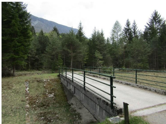
Figura 45 – Attraversamento rio Bondai
