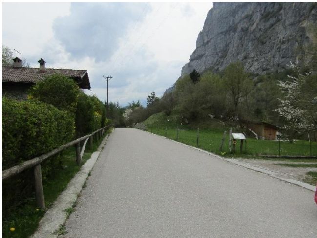
Figura 40 – Dettaglio della strada asfaltata interessata dallo scavo della trincea per la posa del cavo interrato
