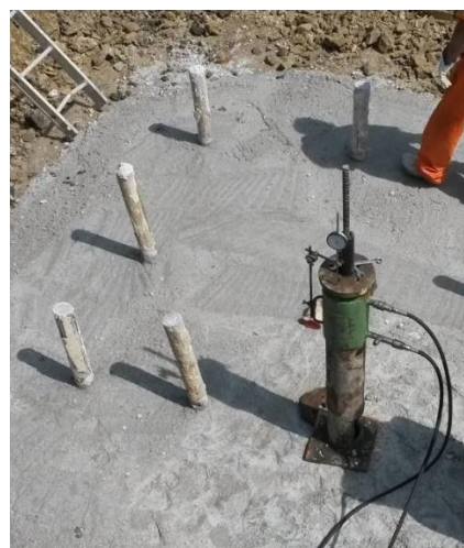
Figura 15: Realizzazione di micropali tipo tubfix per sostegno a traliccio. Particolare di micropali già realizzati ed iniettati prima dell'armatura e cassetteratura del plinto di fondazione.
