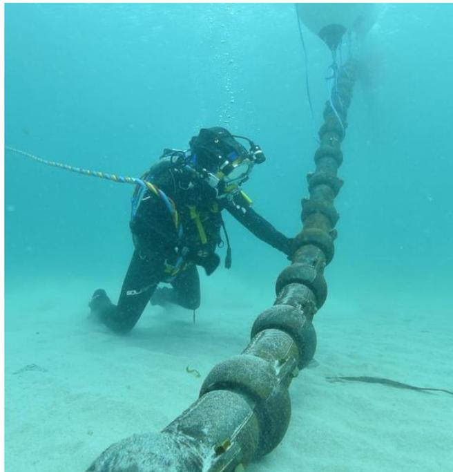
Figura 3.12: Esempio di metodo di posa con gusci di protezione
