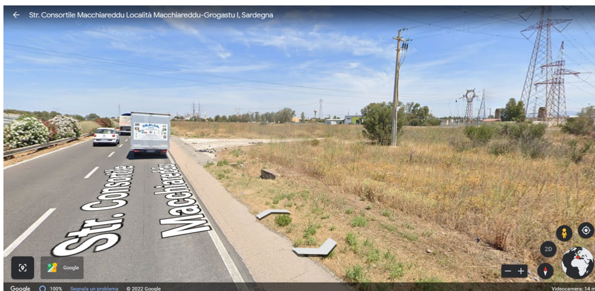
Vista 12: Deviazione del cavidotto a 220 kV in direzione est per arrivo nelle immediate vicinanze della SE Rumianca 380 kV di Terna S.p.A. situata nel comune di Assemmini (CA).
