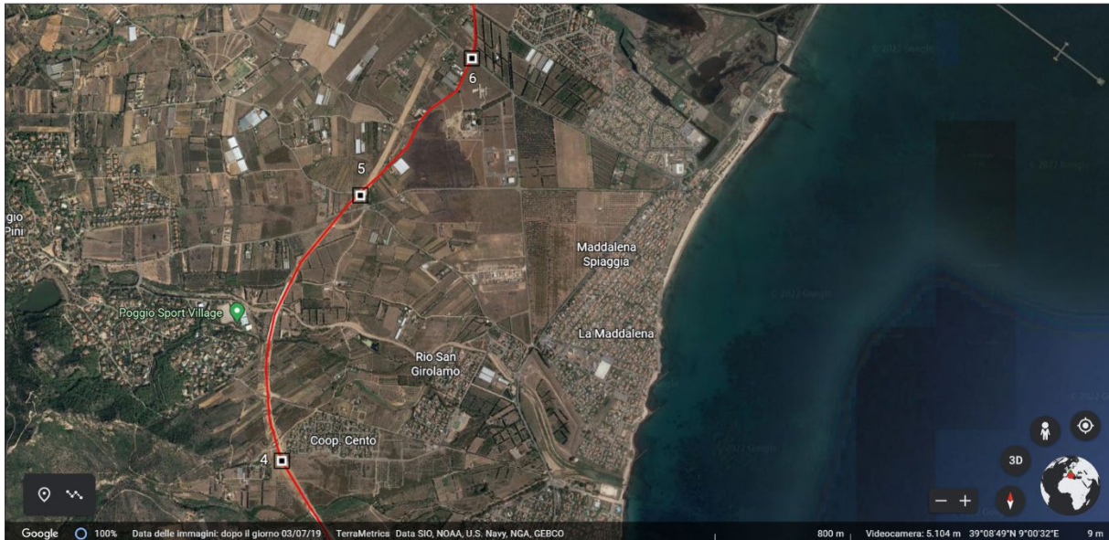
Panoramica del percorso del cavidotto a 220 kV in prossimità della località La Maddalena (CA).
