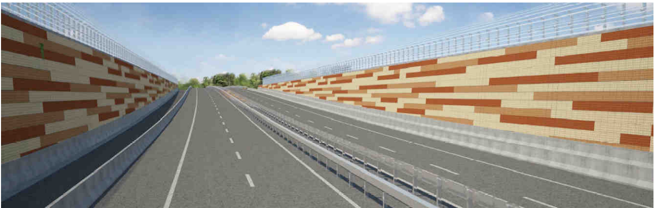
FIGURA 5-11 –VISTA LATO SORGENTE DEL TRATTO IN TRINCEA DI S. GIACOMO RONCOLE CON IL RIVESTIMENTO DEI MURI IN MATERIALE FONOAASSORBENTE (TIPO ARGILLA ESPANSA)
