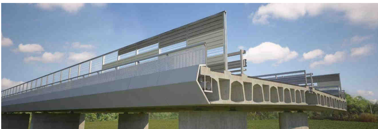
FIGURA 4-30 – SOLUZIONE ARCHITETTONICA VIADOTTO CON IMPALCATO IN CAP
