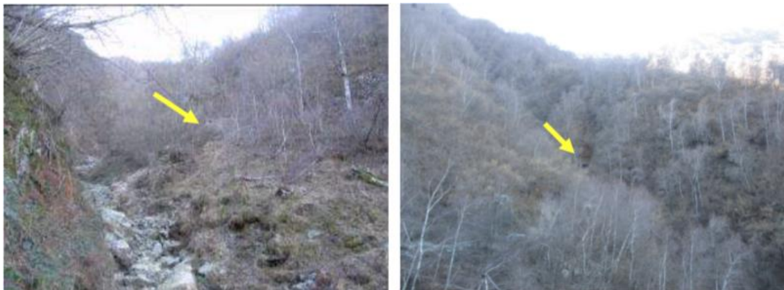
Figura 7. Zone circostanti l'ingresso della galleria Livello -2 Val Toppa
