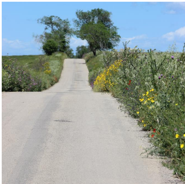
Viabilità in conglomerato bituminoso esistente
