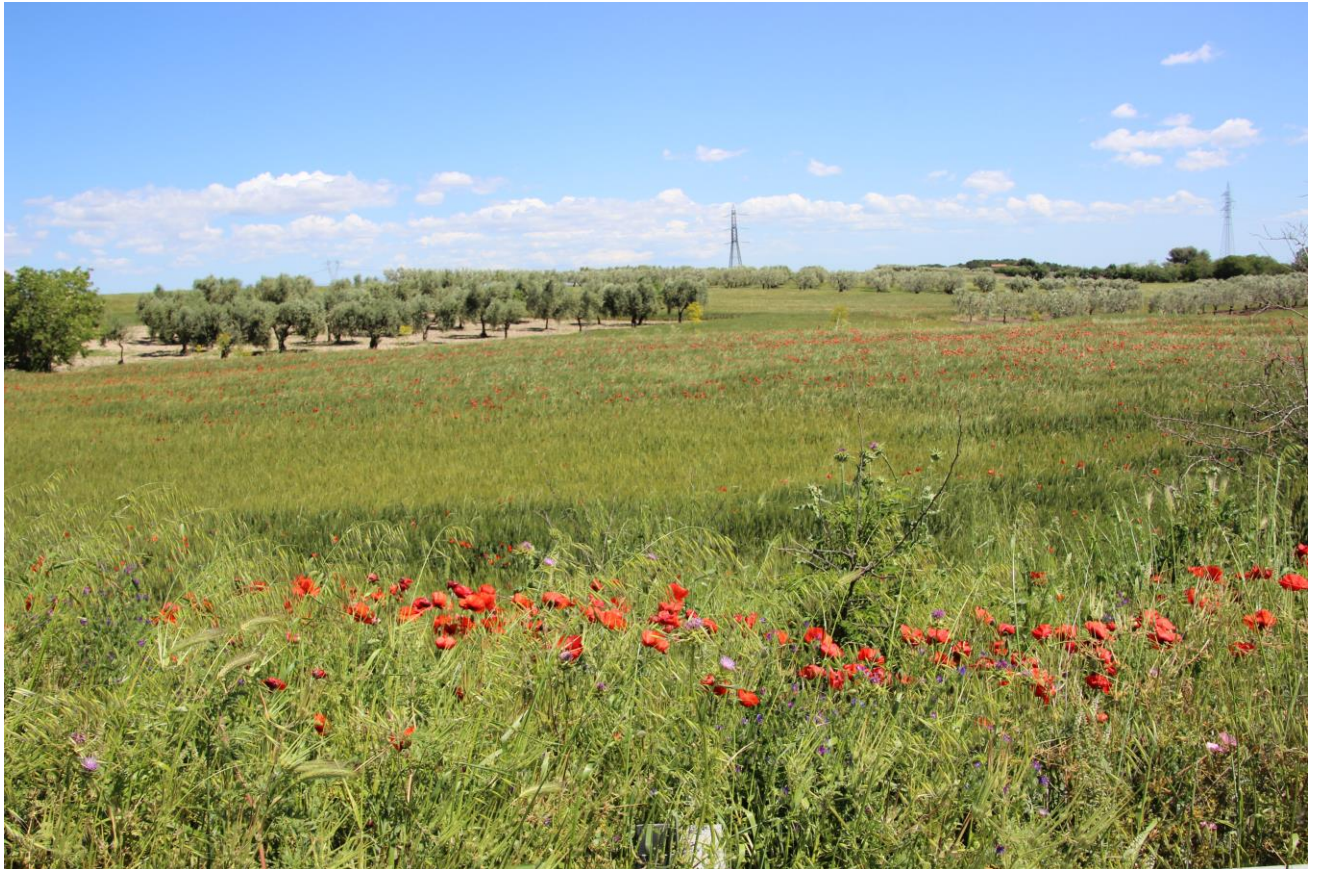
Accesso WTG 10 – Realizzazione nuova viabilità parco eolico
