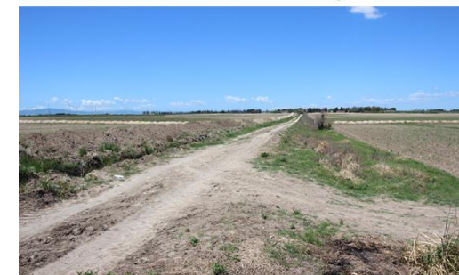
Accesso WTG 7 Viabilità esistente con pavimentazione naturale in pessimo stato
