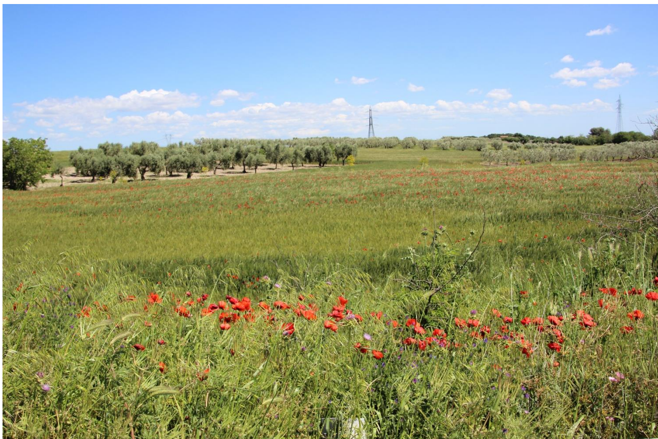
Accesso WTG 10 – Realizzazione nuova viabilità parco eolico
