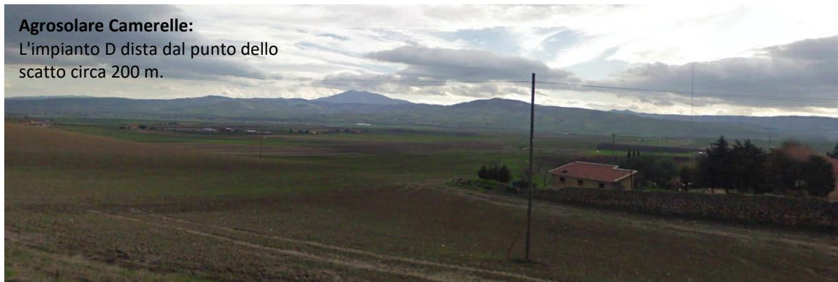
Figura 32 – foto dalla SP97 verso l’impianto D
