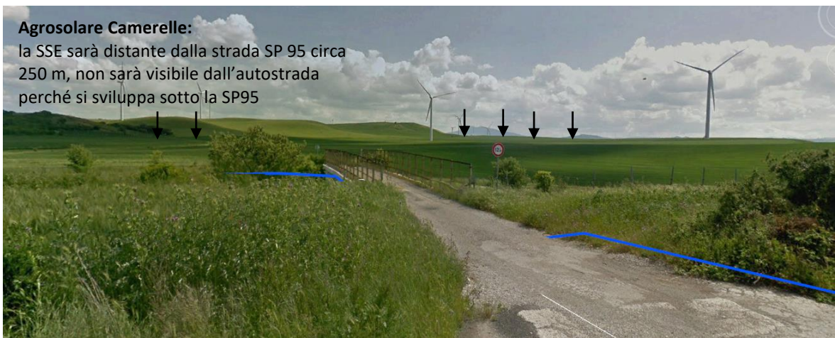
Figura 11 – foto dalla SP95 verso la sottostazione Utente SSE
