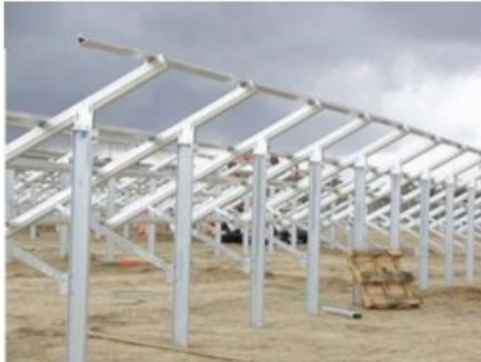
Si procede poi con l'estrazione delle strutture di sostegno con apposito macchinario. Le strutture di sostegno moduli completamente riciclabile e facilmente estraibili dal suolo in fase di dismissione.
