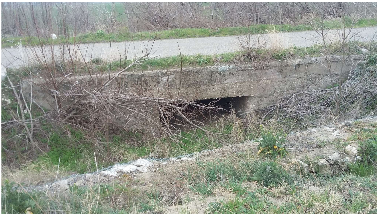
Fig.B 8: Foto attraversamento 12
