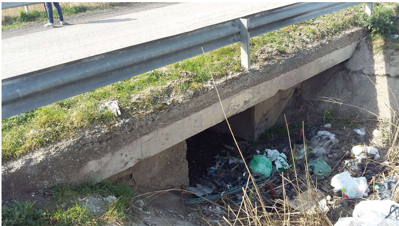
Fig.B 5: Foto attraversamento 07
