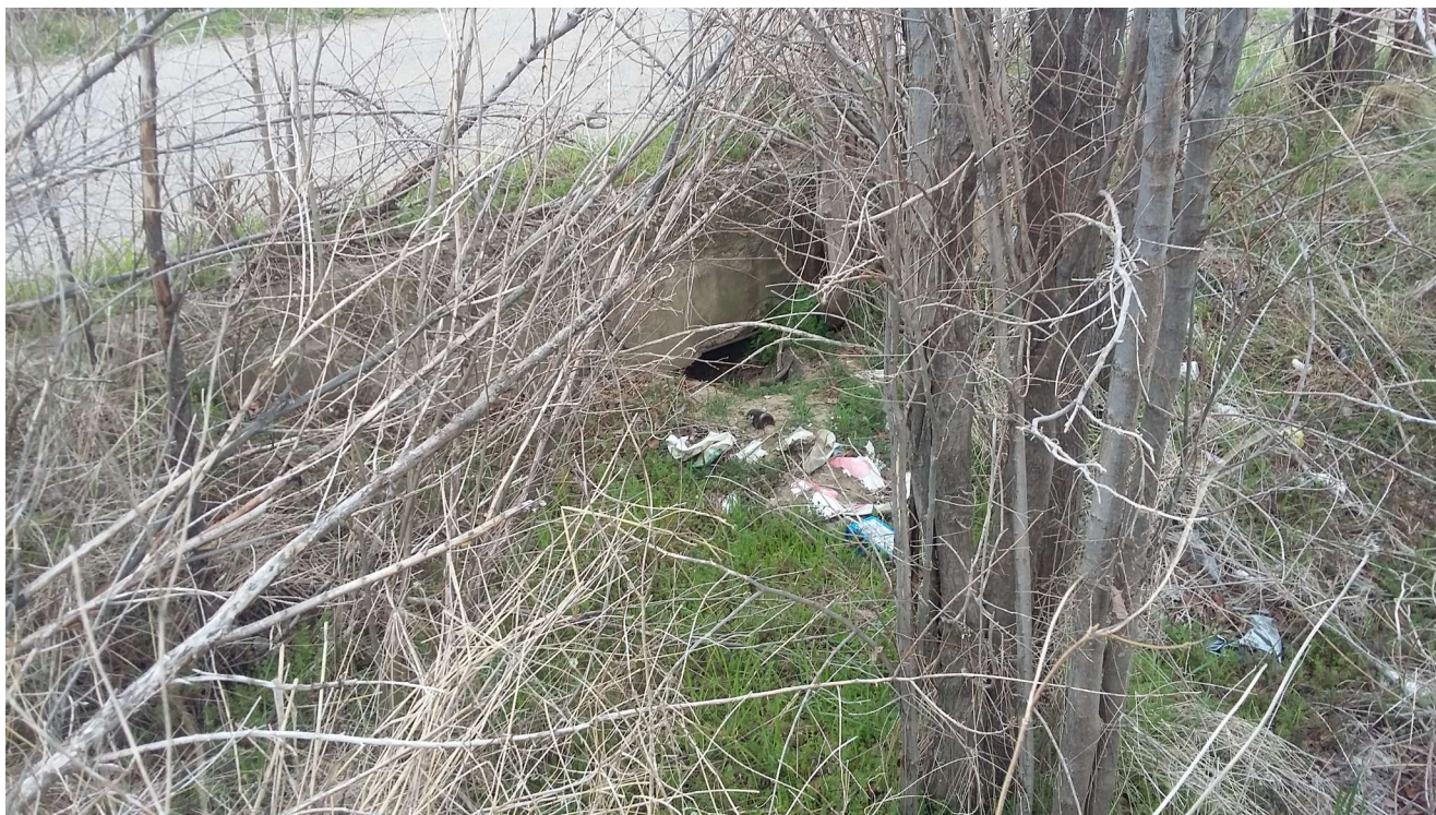
Fig.B 9: Foto attraversamento 13
