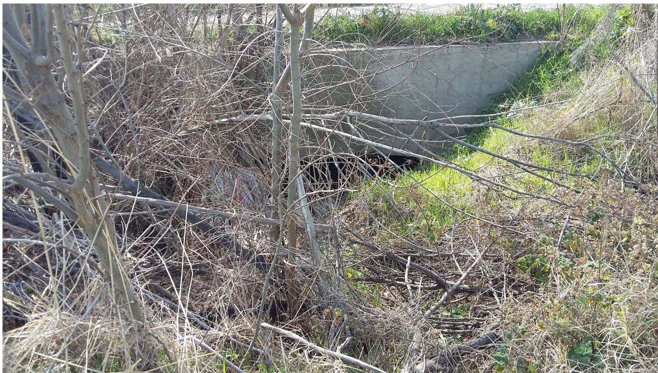
Fig.B 7: Foto attraversamento 09
