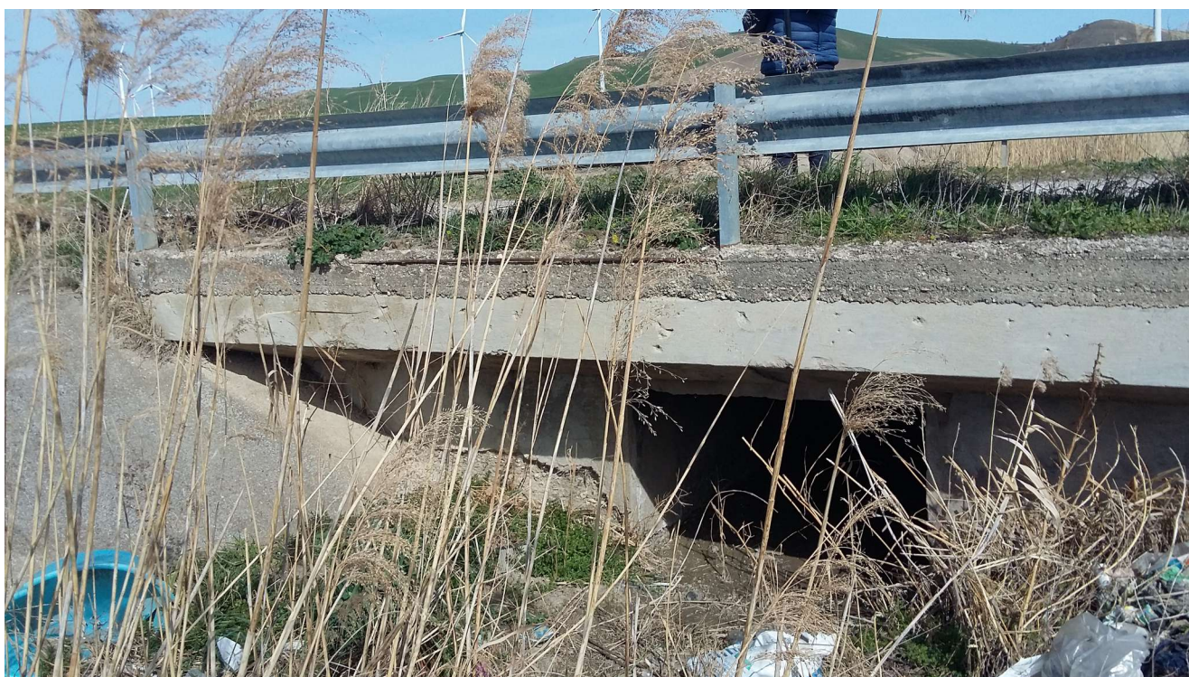
Fig.B 6: Foto attraversamento 08
