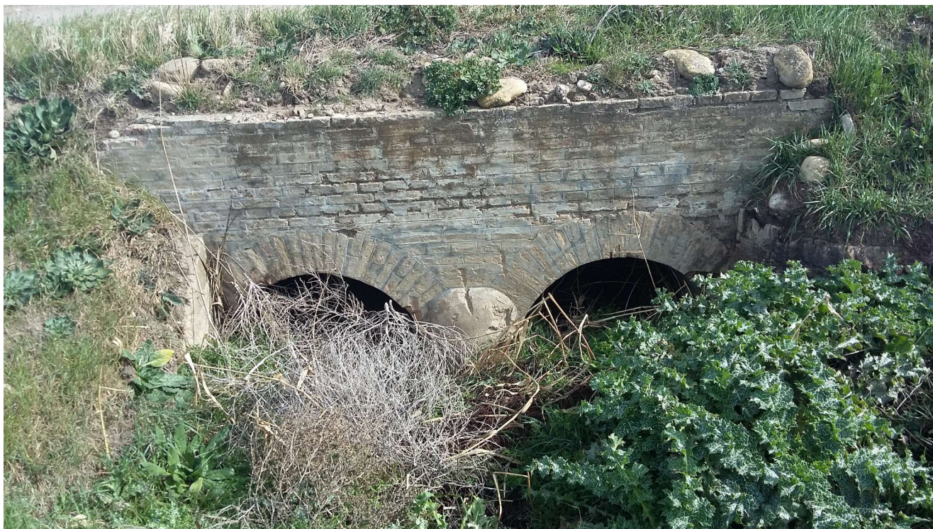
Fig.B 1: Foto attraversamento 01
