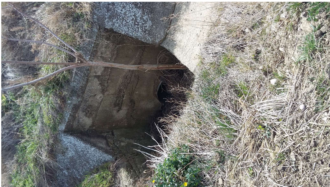
Fig.B 2: Foto attraversamento 04
