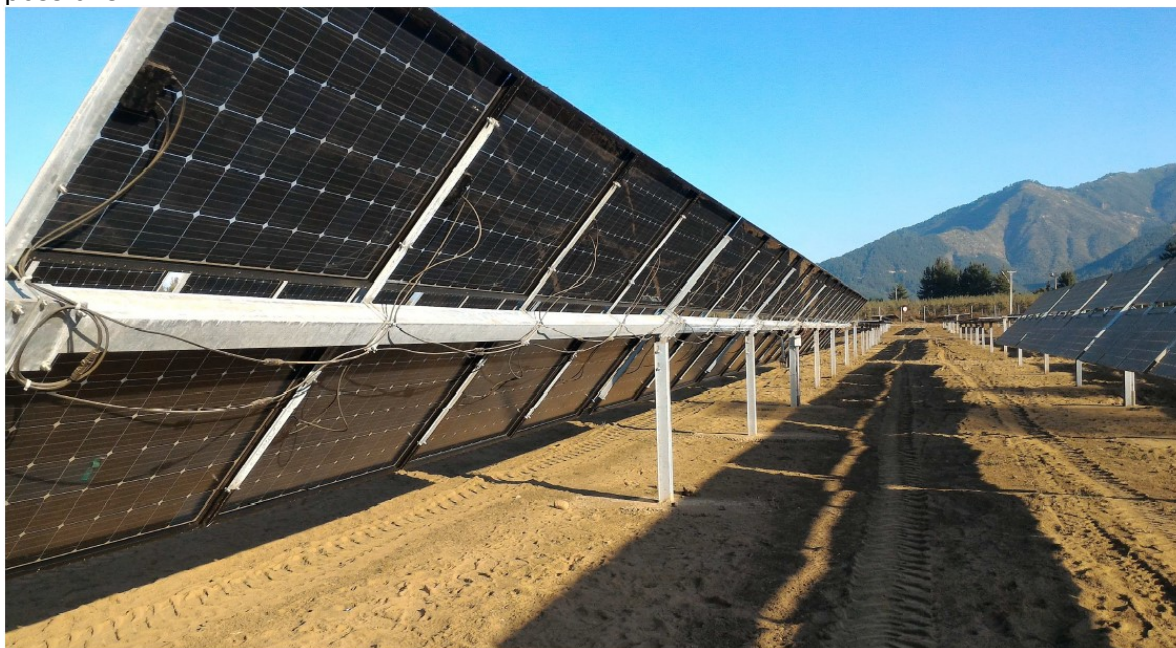
Figura 22 – Foto del Tracker (inseguitori) TRJ
