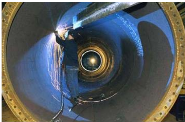
Figura 10: interno di una torre
