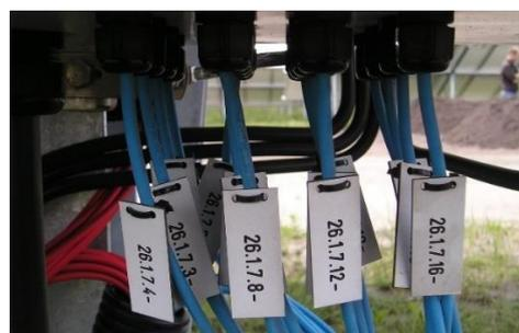
2. connessioni in corrente alternata (bassa tensione)
