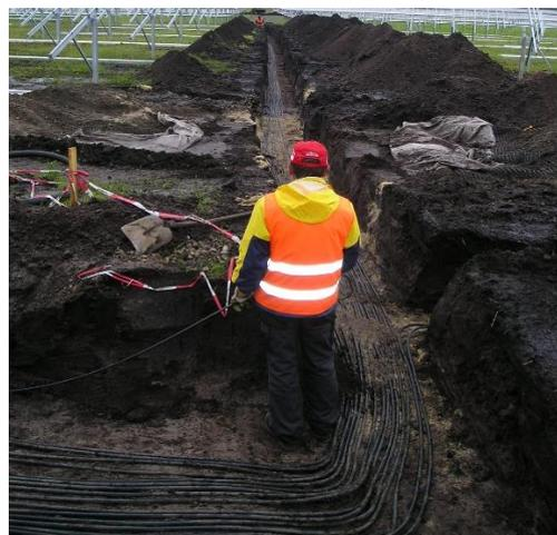
3. connessioni in corrente alternata (media tensione):
