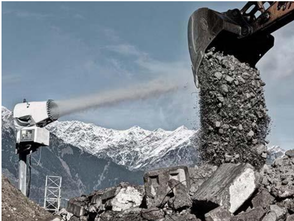
Figura 88 - Cannoni nebulizzatore polveri di cantiere
