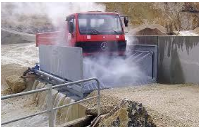
Figura 11 - Lavaggio ruote mezzi di lavoro
