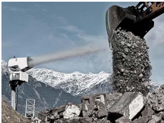
Figura 12 - Cannoni per nebulizzazione polveri
