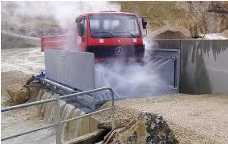
*Figura 5 - Lavaggio ruote mezzi di lavoro*
