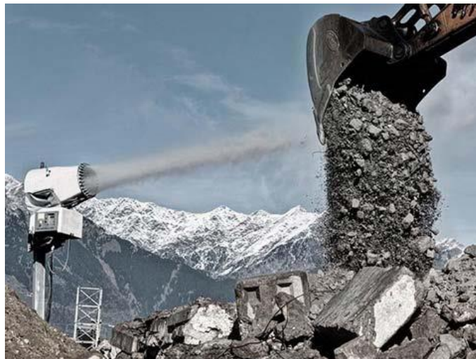
Figura 3 - Cannoni per nebulizzazione polveri
