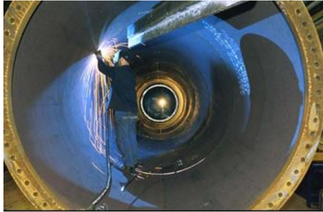
Figura 10: interno di una torre
