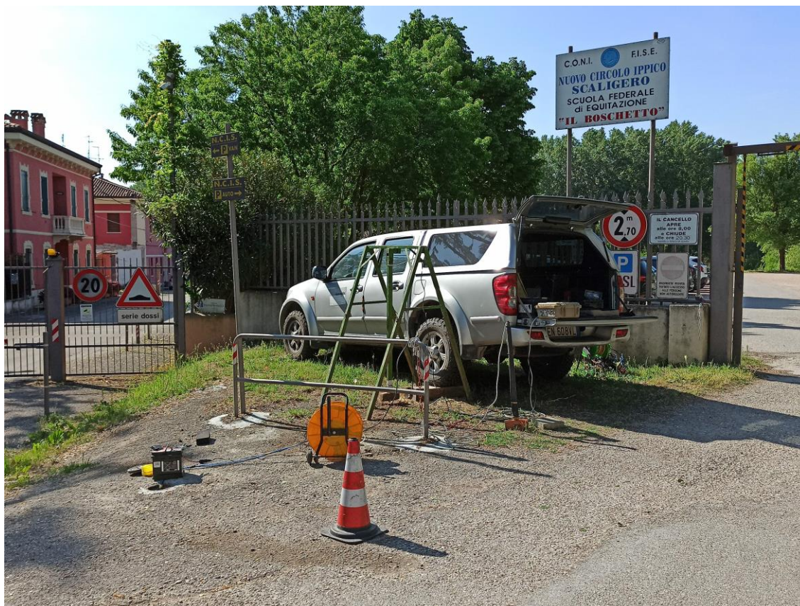
Figura 26: foto relativa all'esecuzione della prova down-hole VR1.
