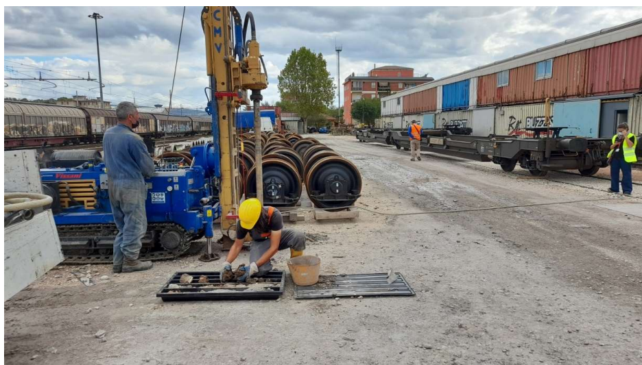
Figura 59. Veduta della parte meridionale dell'area ferroviaria di Porta Vescovo
