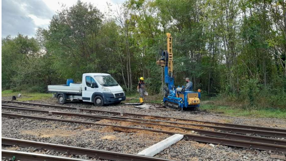
Figura 60. Esecuzione dei carotaggi nell'area ferroviaria di Porta Vescovo
