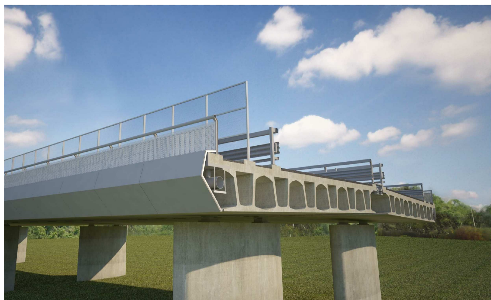
SIMULAZIONE - DETTAGLI IMPALCATO E CARTER METALLICO
