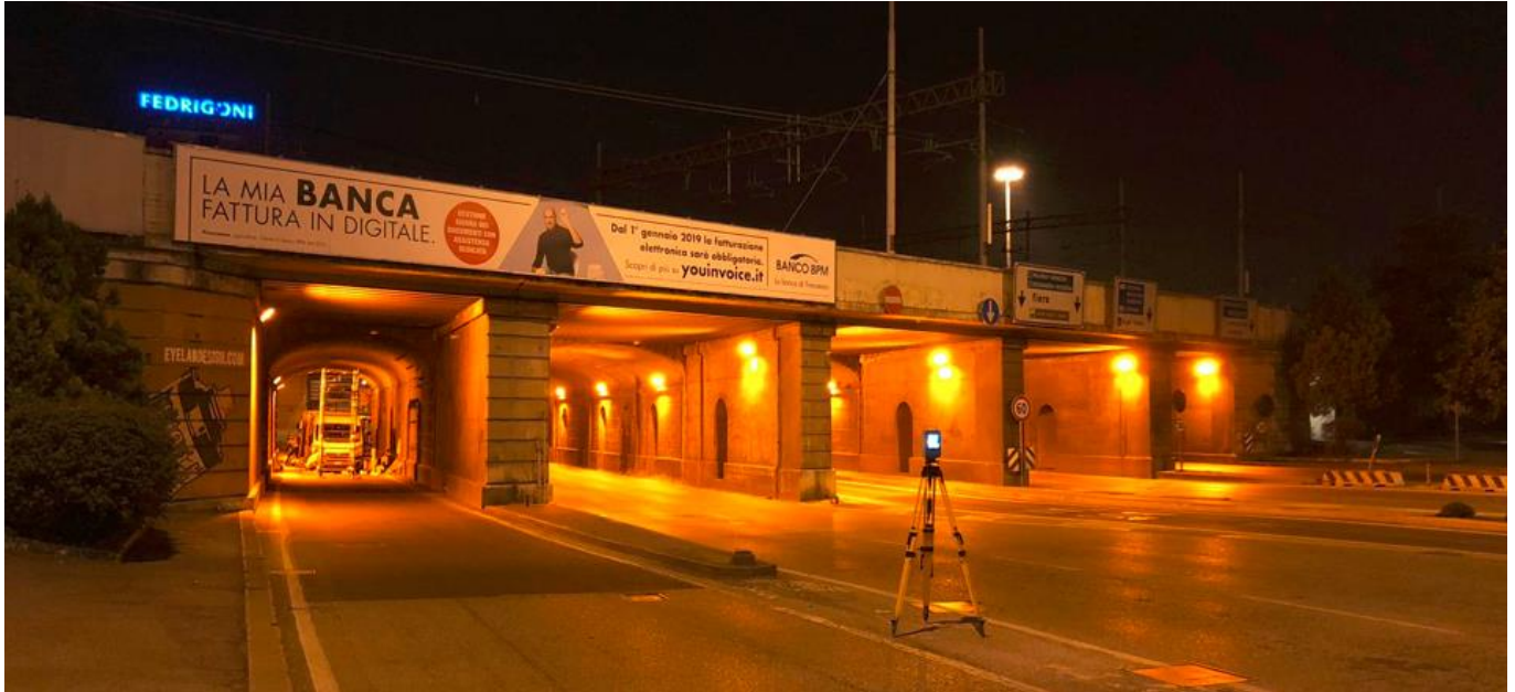
Figura 3 – Opera in oggetto – Prospetto nord Sottovia km 144+851
