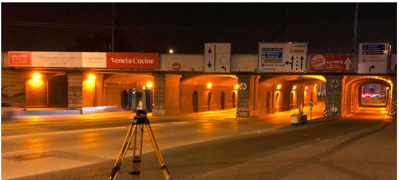
Figura 4 – Opera in oggetto – Prospetto sud Sottovia km 144+851
