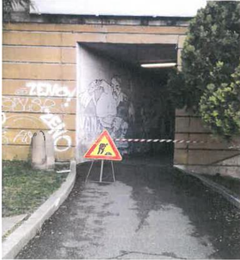
Figura 3 – Opera in oggetto – Sottovia km 147+885
