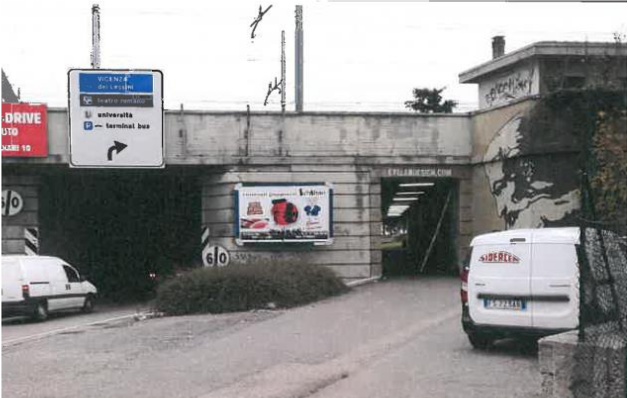
Figura 4 – Opera in oggetto – Sottovia km 147+885
