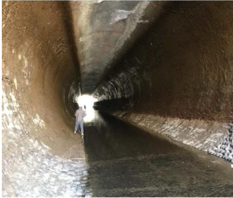
Figura 3 – Opera in oggetto – Ponte Camuzzoni km 147+800
