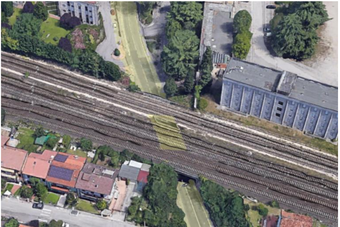
Figura 2.1 Vista aerea dell'opera
