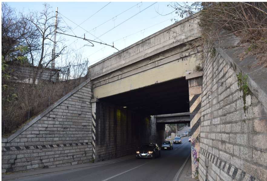
Figura 3 – Viste dello scatolare esistente
