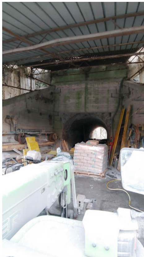
Figura 4 –Opera in oggetto vista Nord
