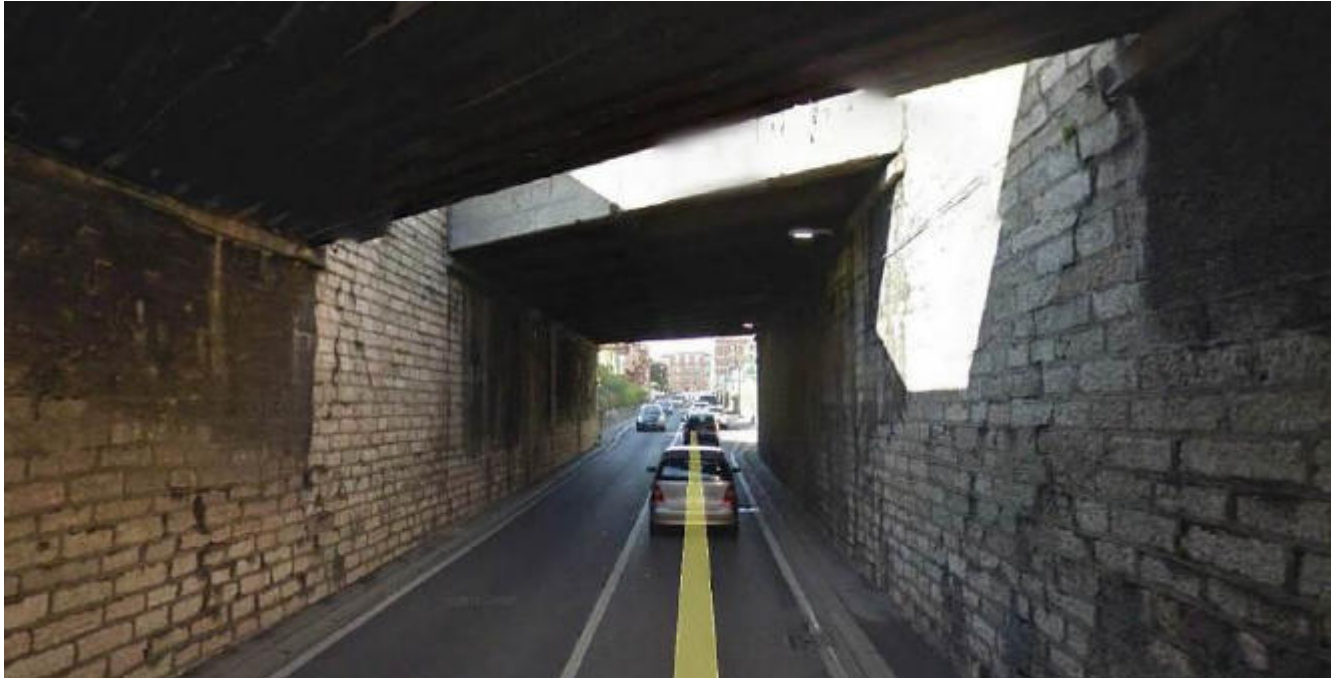
Figura 3 – Vista dello scatolare esistente
