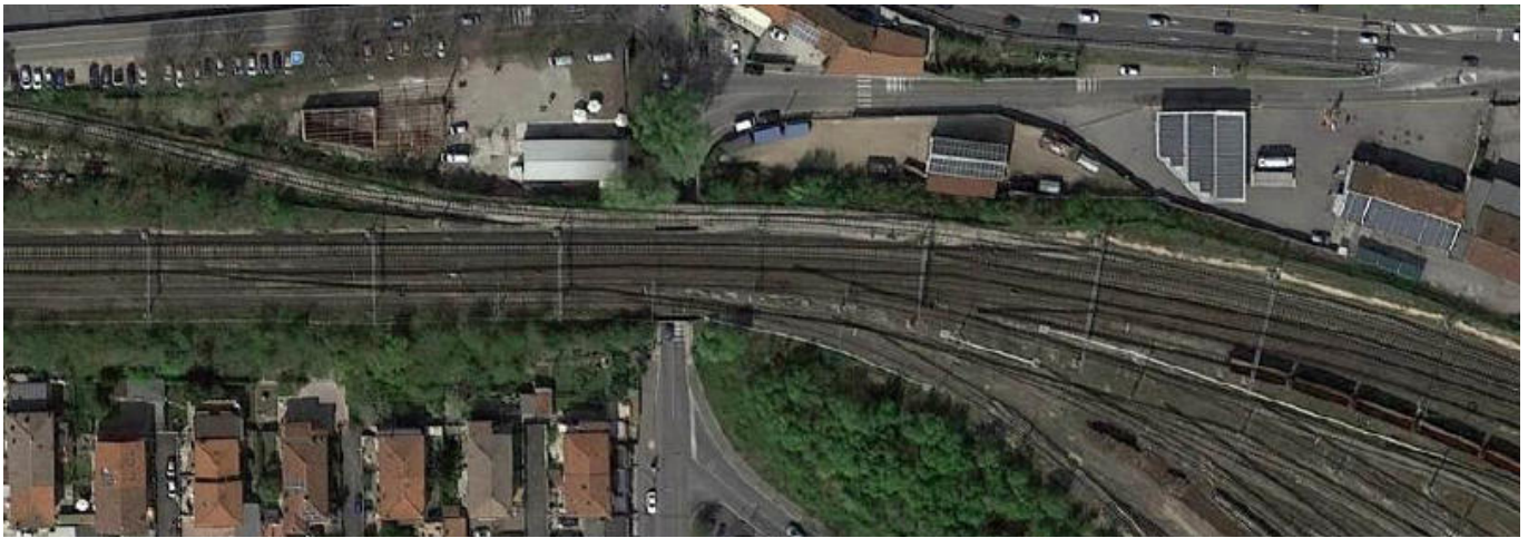
Figura 2 – Stato di fatto
