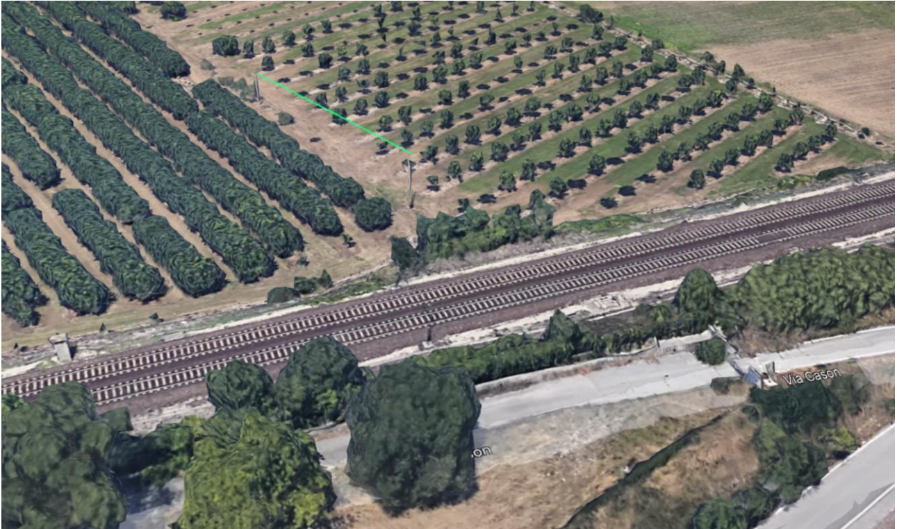
— Linea elettrica aerea
