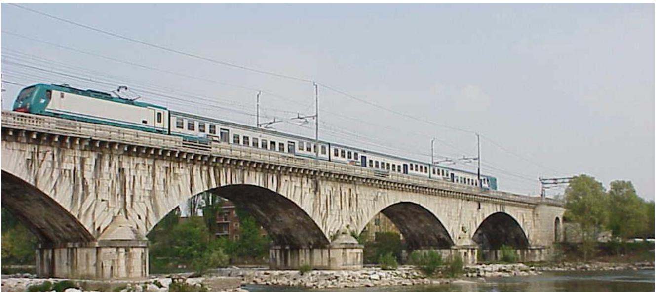
Figura 1 - Viadotto sul fiume Adige – Linea storica Campate centrali di luce 34 m - Punto di presa a sud del viadotto
