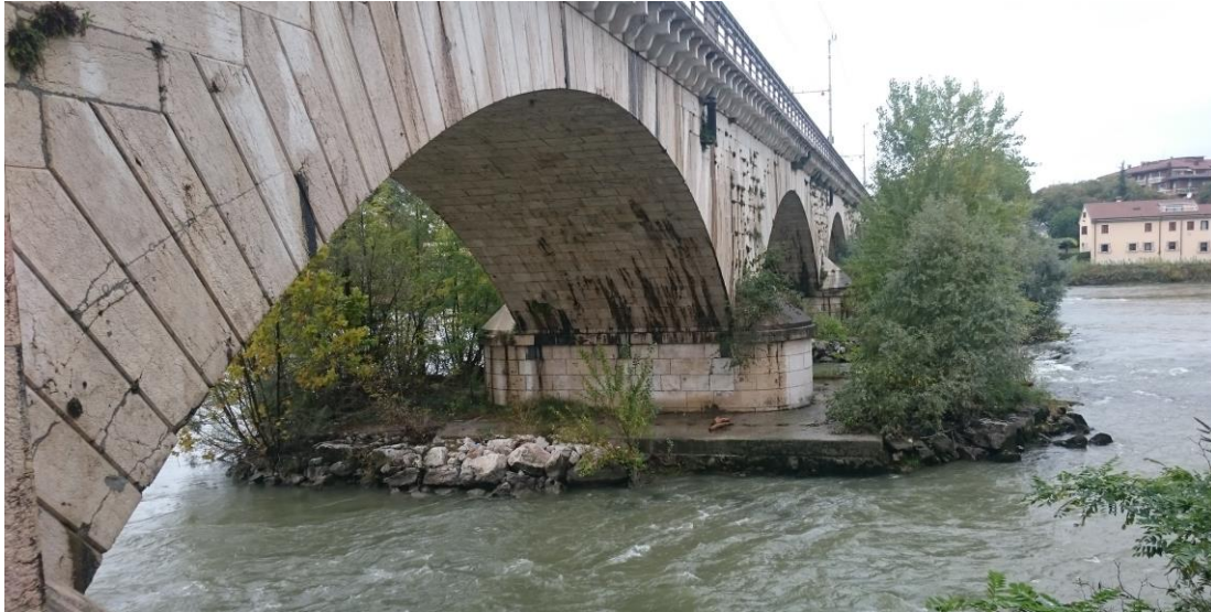
Figura 8: Blocchi di consolidamento delle pile del ponte ferroviario esistente della linea storica Milano – Venezia.
