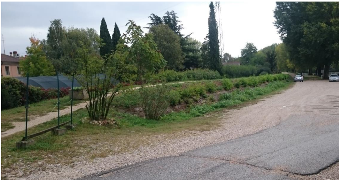
Figura 9: Argine di recente realizzazione in sinistra idraulica (2013).
