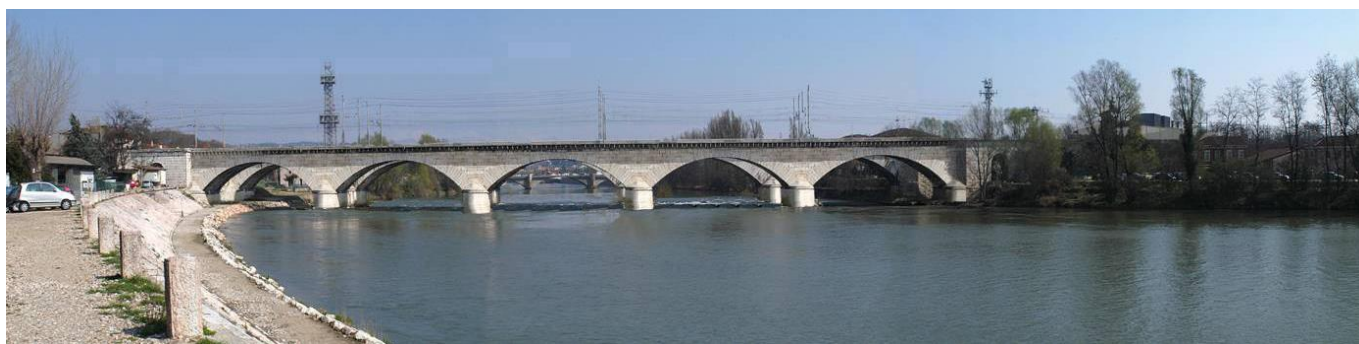
Figura 10: Foto di inserimento del nuovo ponte ferroviario.
