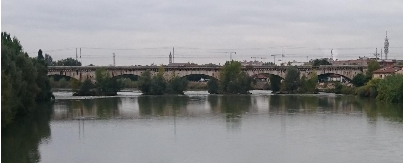
Figura 1: Ponte ferroviario esistente.
