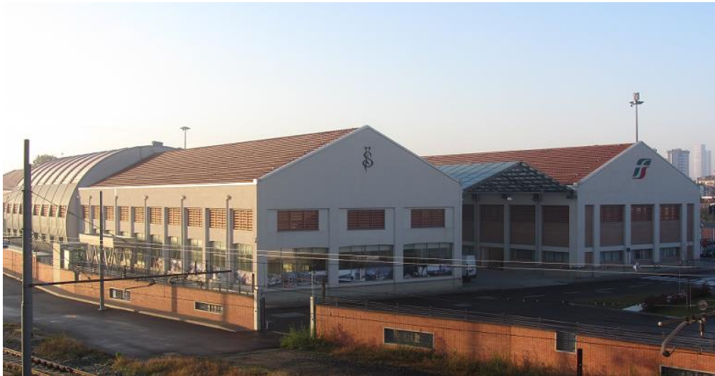
Figura 17 – Posto Centrale Milano Greco Pirelli
