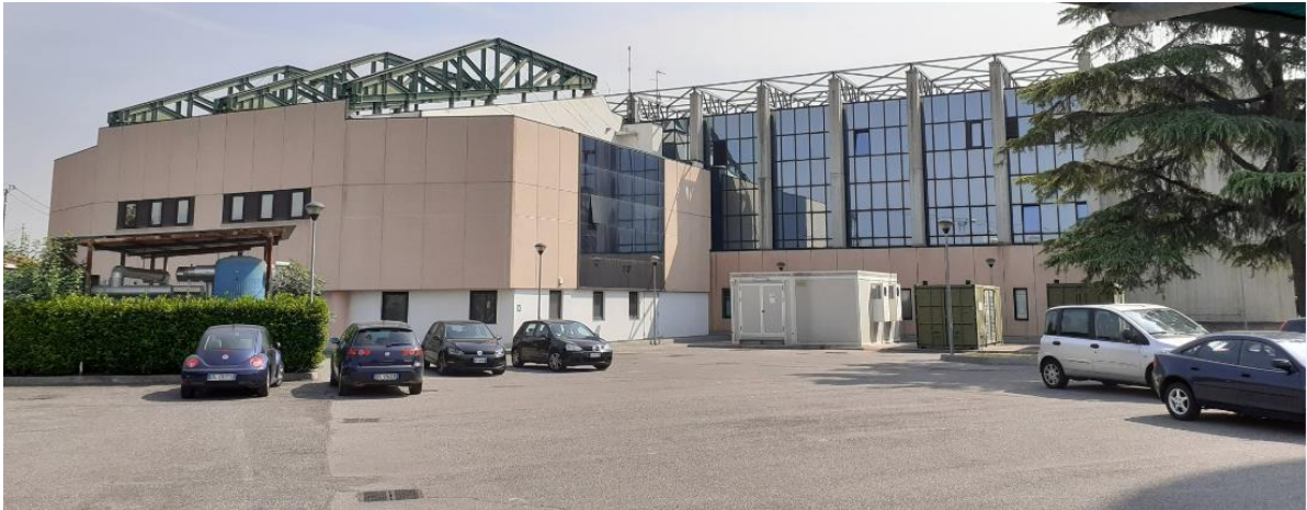
Figura 13 – Fabbricato attuale Posto Centrale SCC Verona
