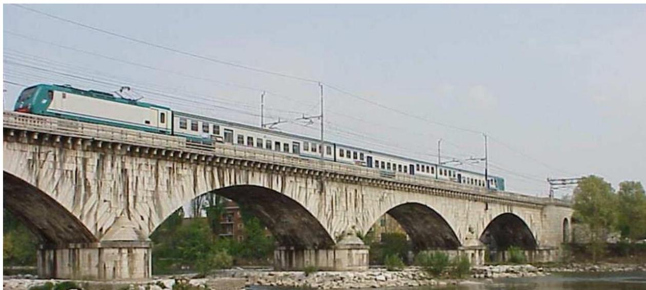
**Figura 2-3 – Viadotto sul fiume Adige – Linea storica. Campate centrali di luce 34 m – Punto di presa a sud del viadotto**
