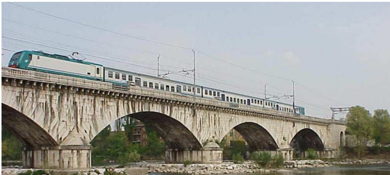
Figura 4-2 – Viadotto sul fiume Adige – Linea storica. Campate centrali di luce 34 m – Punto di presa a sud del viadotto
