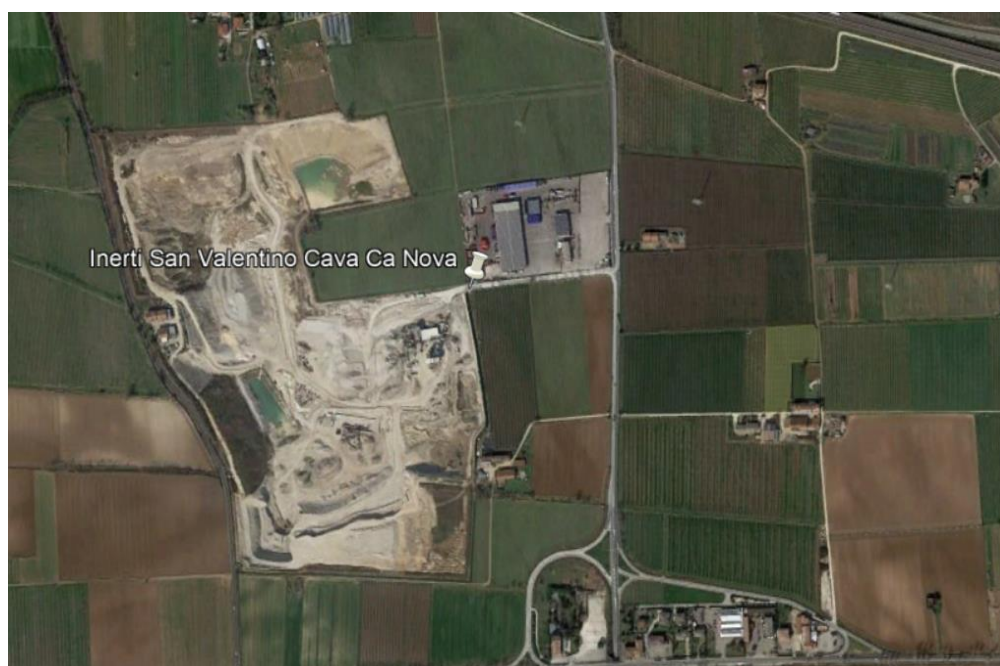
Figura 3-3 – Ditta inerti San Valentino, foto aerea
