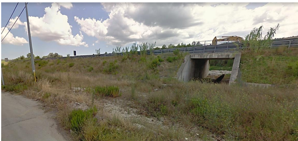
Figura 3-9. Foto scatolare di attraversamento SS80 in uso
