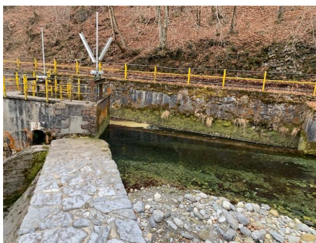
Figura 8. Torrente Riso nei pressi della ex-Laveria
