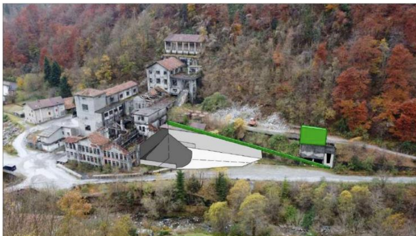
Figura 7. Località Riso. Area tramogge.
