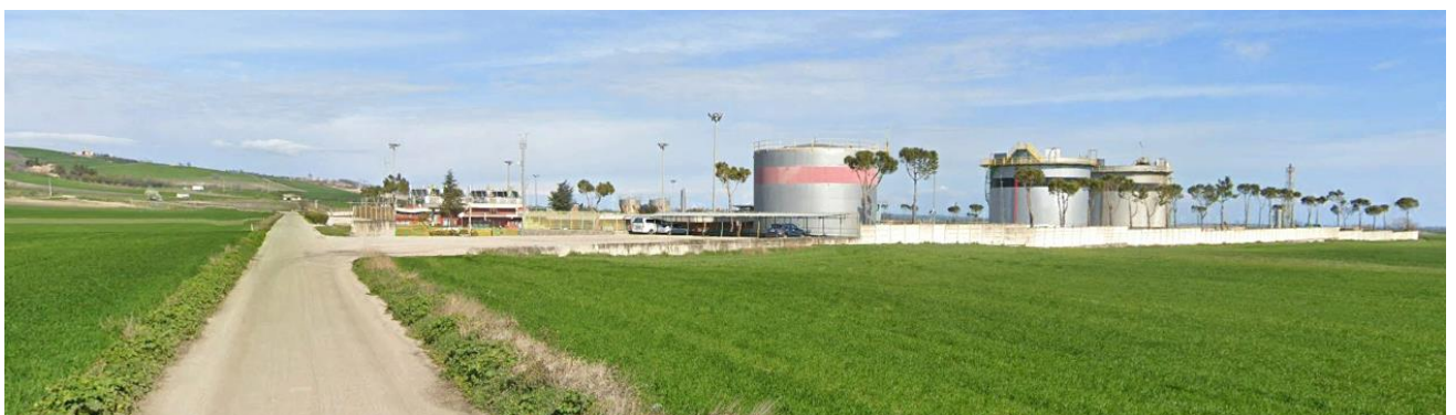
Centrale ENI “Torrente Tona”
