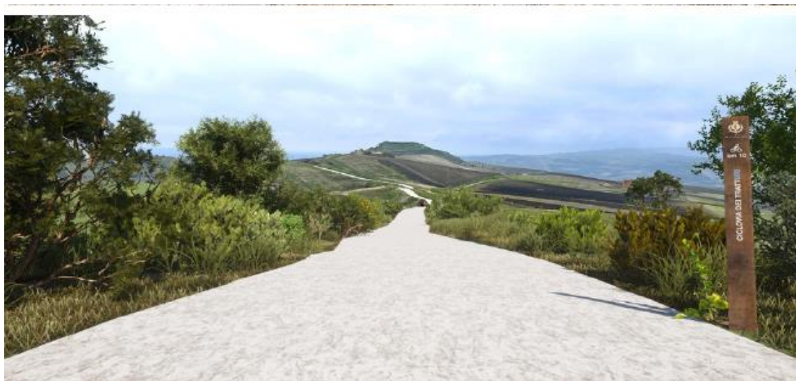
Interventi per la valorizzazione del tratturo Celano-Foggia
