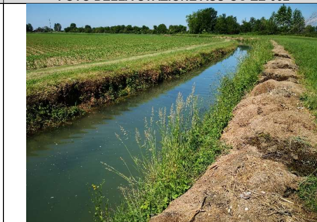
FOTO DELLA STAZIONE ASU-OC-ZE-002
