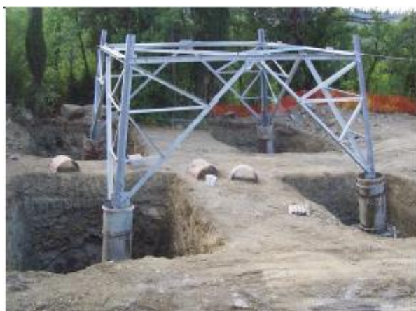
Esempio di fondazione – fonte - Terna
