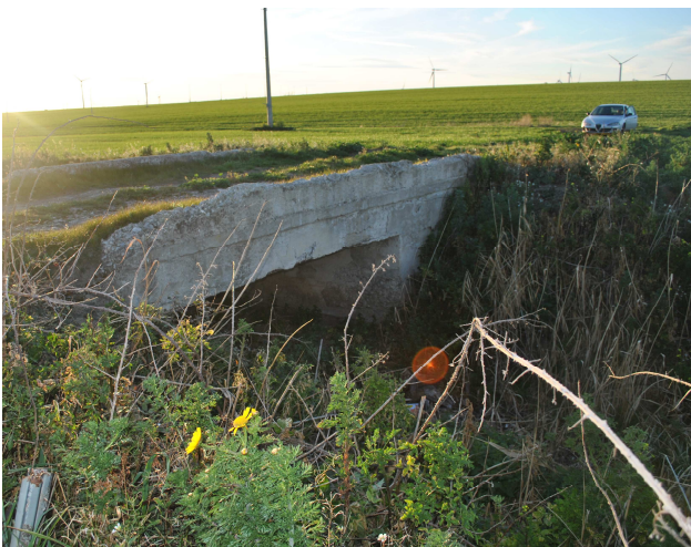
Sovrappasso Canale Ponticello
