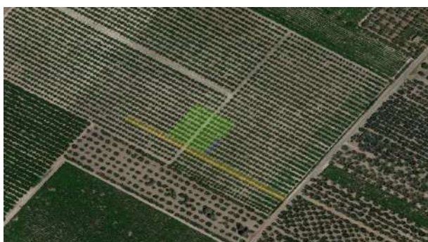
Illustrazione 1.4: Area che ospiterà la stazione di trasformazione in adiacenza alla futura Stazione Elettrica a 380/150 kV della RNT autorizzata.
