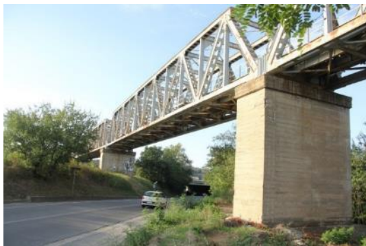
Figura 3-11. Il viadotto ferroviario esistente VI01a di scavalco dell'autostrada A3
