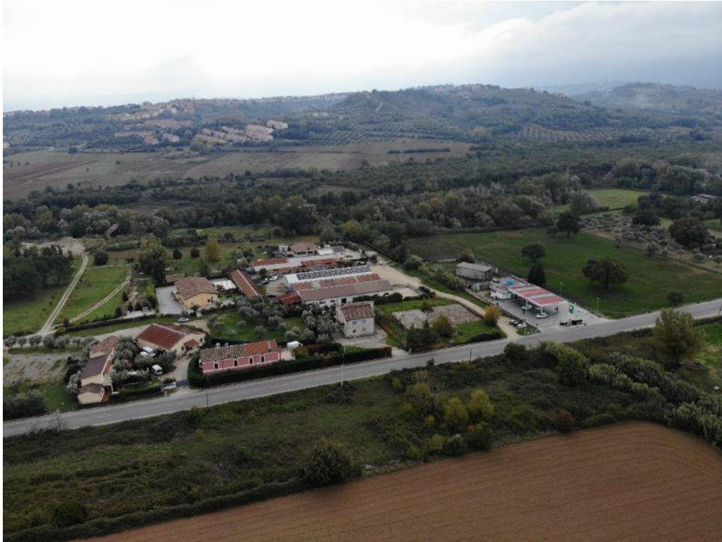
Figura 3-73. Area che si sviluppa lungo l'esistente asse viario della SP 91. Sullo sfondo si osserva il corso del torrente Settimo, il cui tracciato si caratterizza per la presenza di una modesta fascia alberata igrofila
