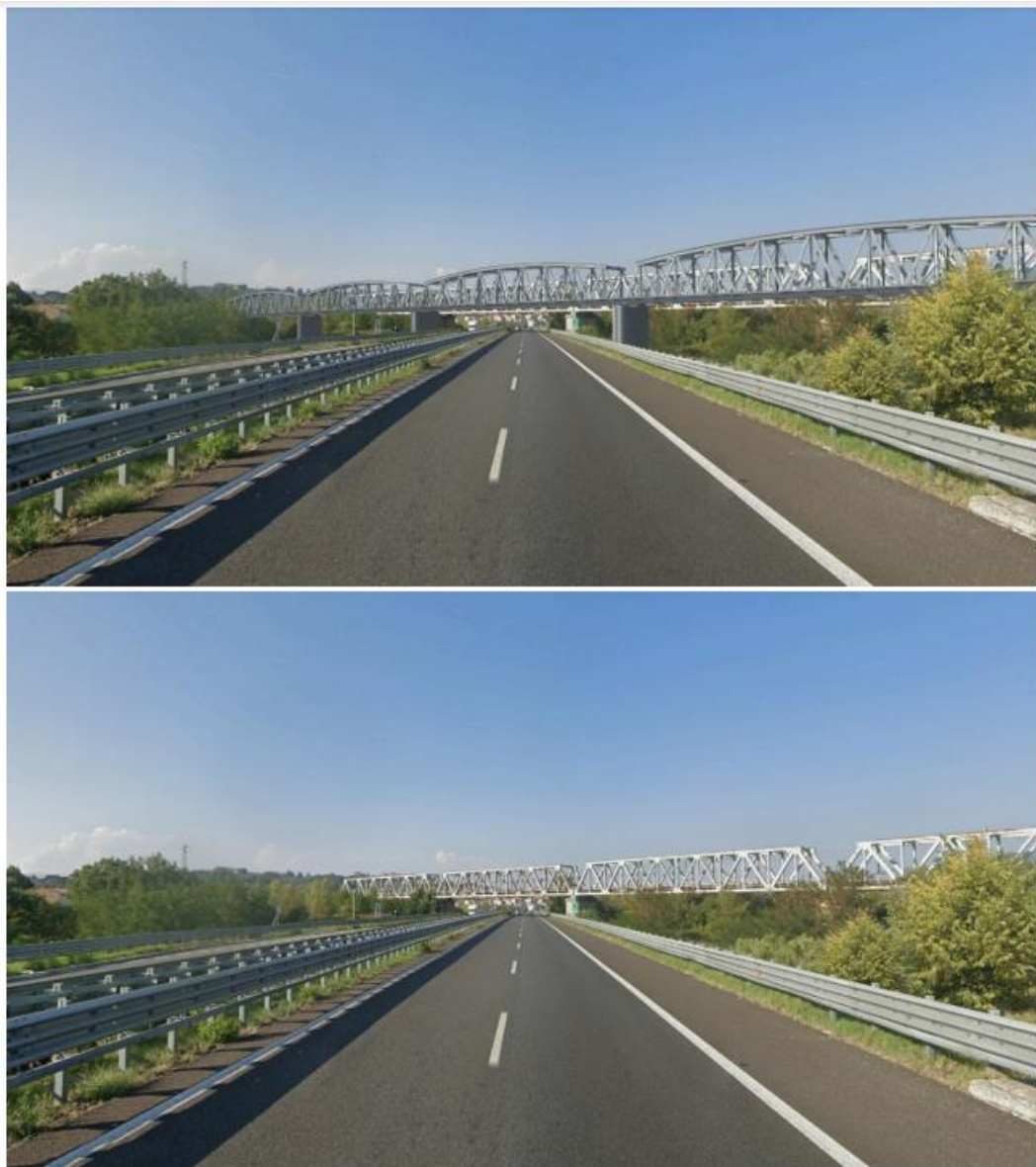
Figura 3-68. Viadotto VI01 Situazione Ante operam e post operam
