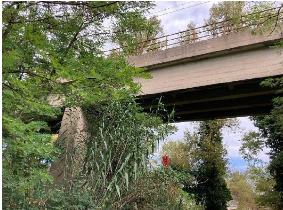
Figura 3-69. Ponte esistente in corrispondenza del torrente Settimo
