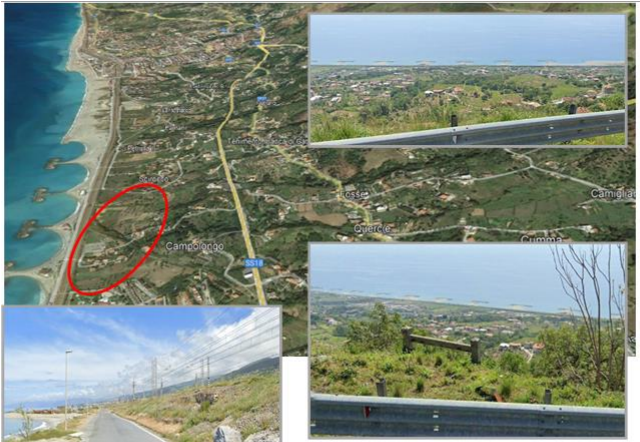
Figura 3-70. Fronti di percezione panoramica in direzione della linea in progetto che si sviluppa all'aperto (cerchio rosso)
