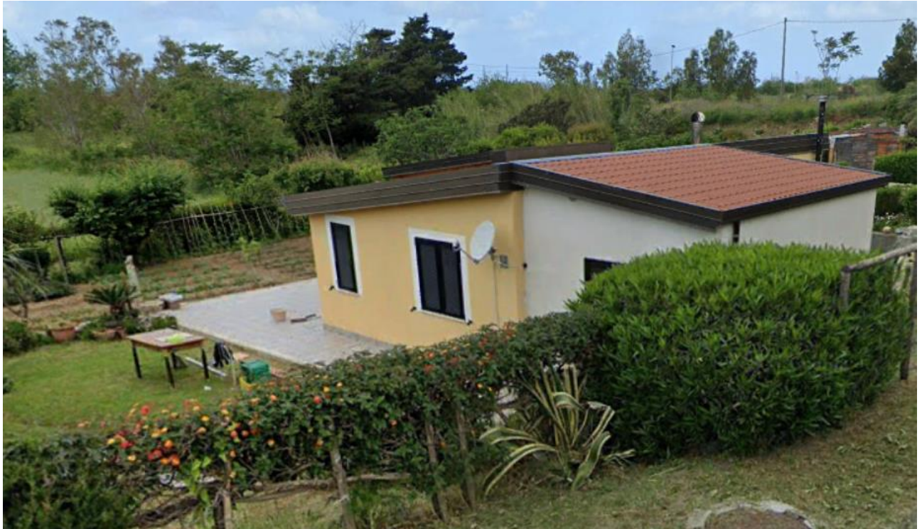
Figura 3-60. Porzione del cantiere operative CO.03 per la quale è prevista la demolizione di un'abitazione
