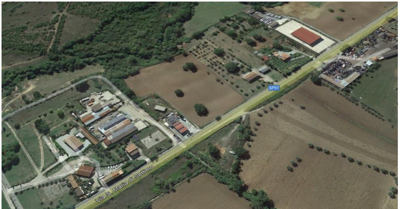
Figura 3-59. Strutture per le quali è prevista la demolizione in corrispondenza della nuova Stazione di Rende e della nuova viabilità
