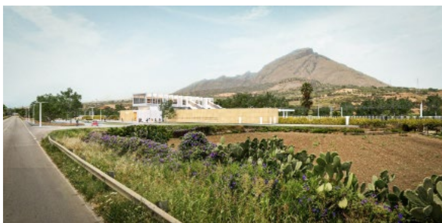
Figura 5 - Stazione di Cerda
