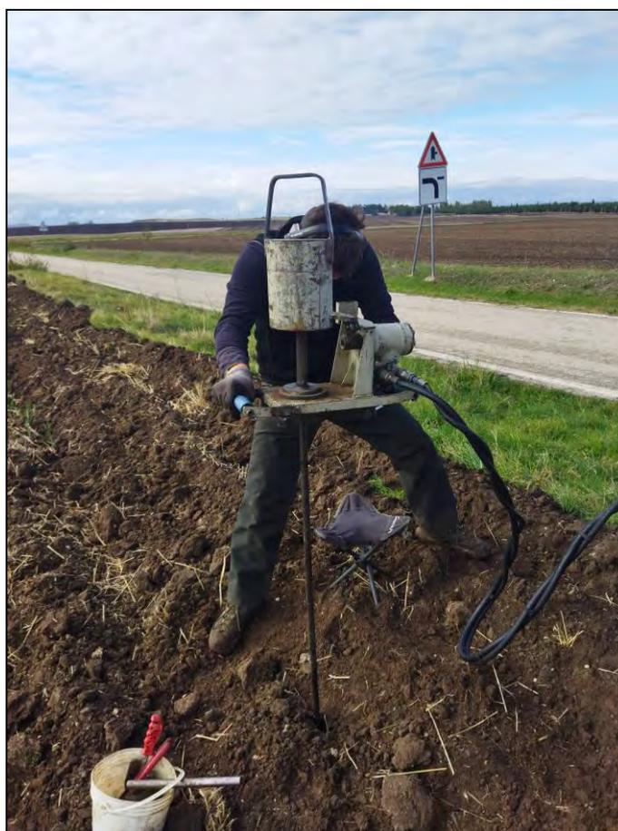
**Fig. 1.1.4.3 – Esecuzione indagine penetrometrica dinamica media – D.P.M. 2.**
