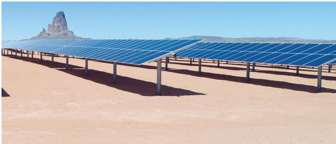
Figura 3-3 - Tipico tracker configurazione portrait (fonte: https://soltec.com/single-axis-solar-tracker/ )
