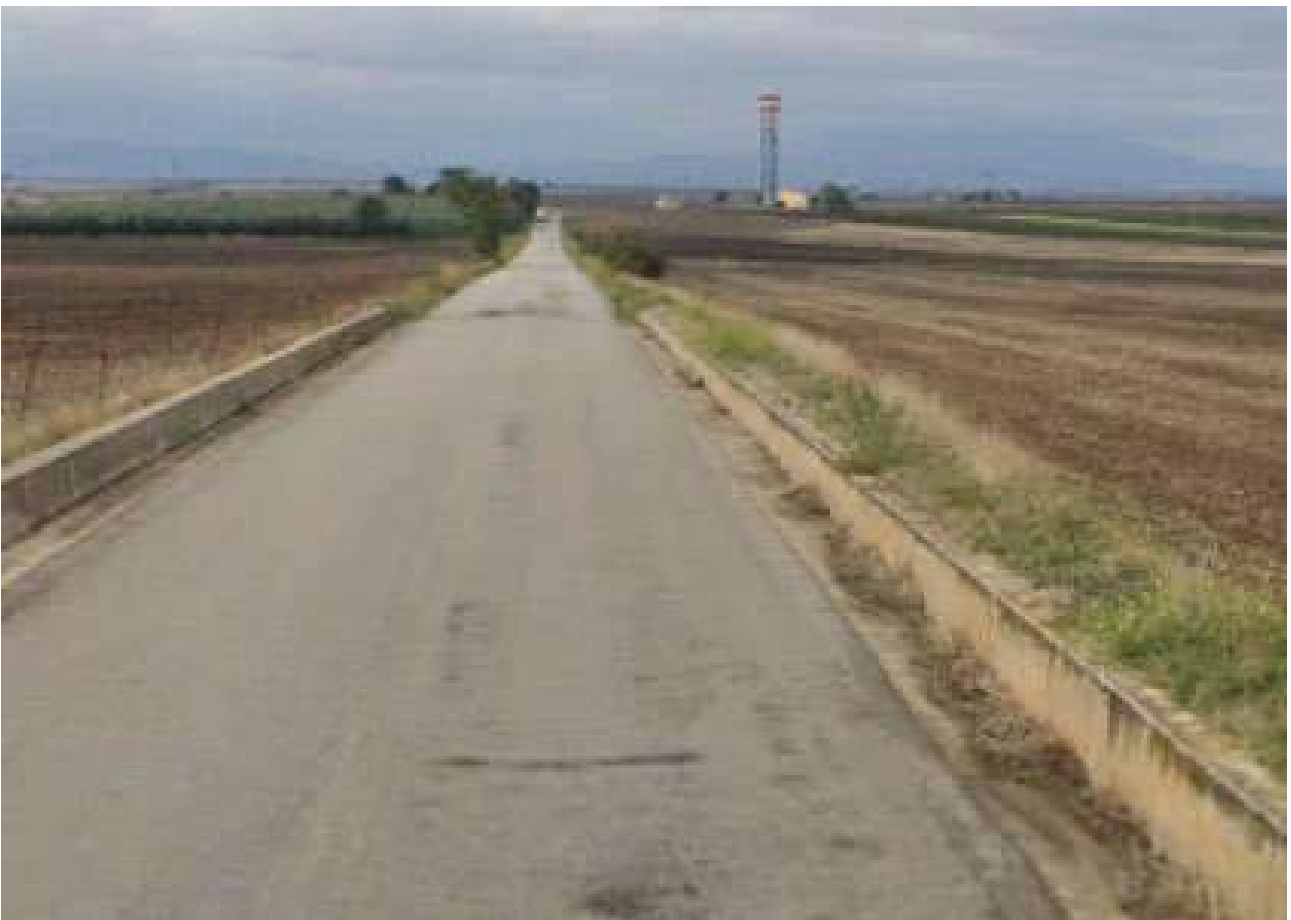
Figura 11.4. – Vista della viabilità interessata dal cavidotto (in direzione SSE)
