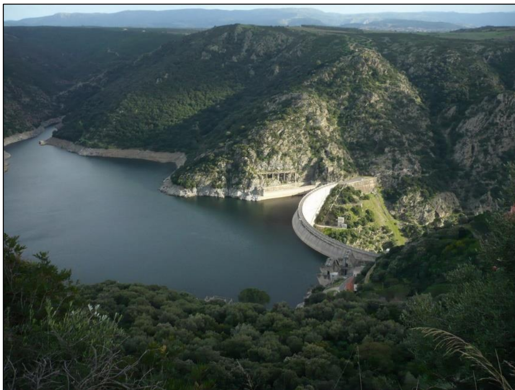
Figura 5-3: Diga di Nuraghe Arrubiu vista da Monte (Fonte: http://www.enas.sardegna.it/il-sistema-idrico-multisetoriale/laghi-artificiali/nuraghe-arrubiu.html )
